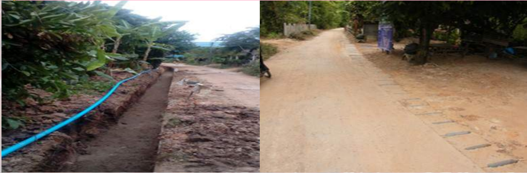
โครงการก่อสร้างรางระบายน้ำซอยกระบวยหัวหย่อน 1 หมู่ 3
