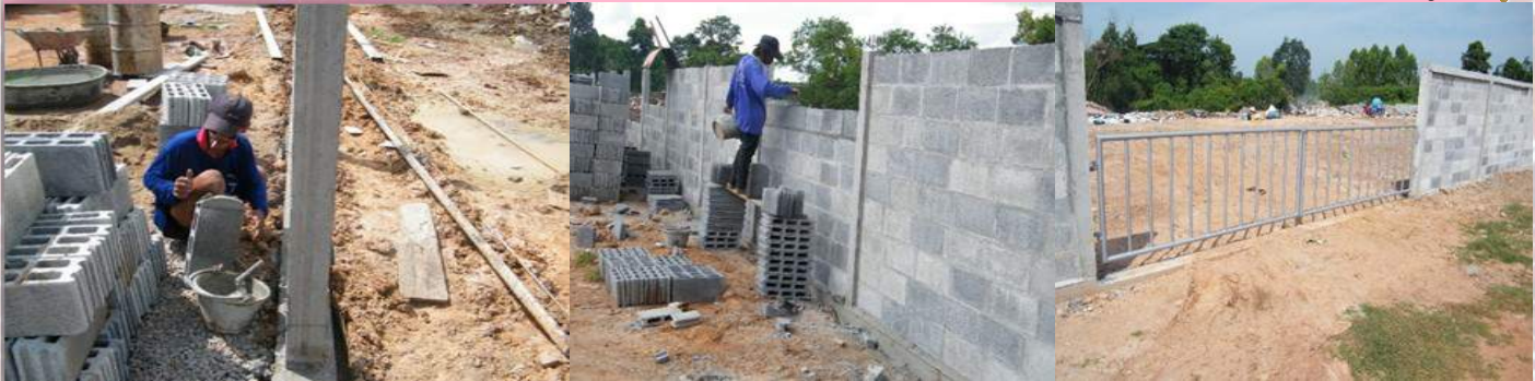
โครงการก่อสร้างรั้ว, กำแพงบ่อทิ้งขยะเทศบาล หมู่ 5
